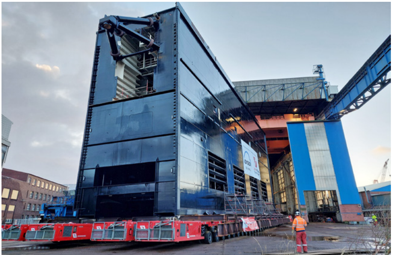
Es wurden bereits die drei neuen Schleusentore fertiggestellt. Jedes Tor ist 21 m hoch, 47 m lang, 9 m breit und wiegt 2,4 t.
